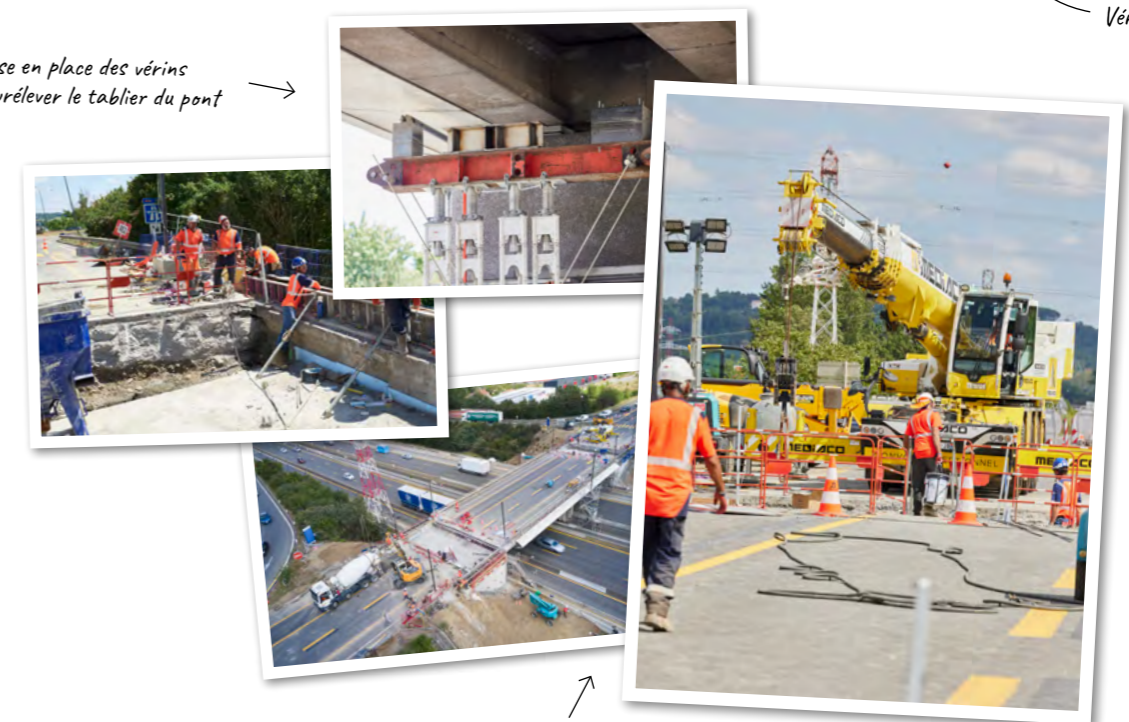
Déblocage du tablier du pont de quelques centimètres pour installer les nouveaux appareils d'appui
