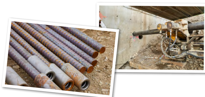
← Insertion des tirants d'enserrements dans les murs du pont
