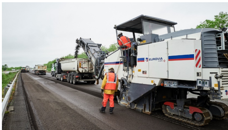
Travaux de rabotage de la chaussée – Photo : ©JP Moulet
